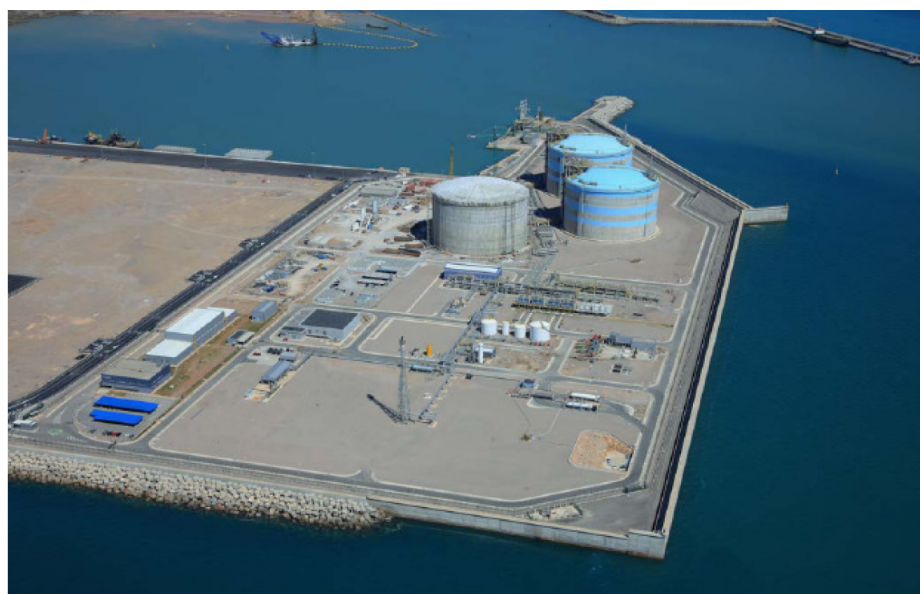
Figura 2. Tanques de armazenagem criogênica de gás (GNL) em Sagunto, Espanha, de aproximadamente 55 m de altura e 74 m de diâmetro cada (4,6cm x 10,9cm) [8].
