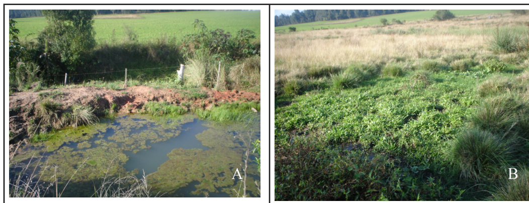
Figura 3. A) Construção de fossas irregulares na margem esquerda da Sanga Lagoão do Ouro. B) Área com “banhado” devido à presença de esgoto irregular. Santa Maria (RS) 10/2006.
