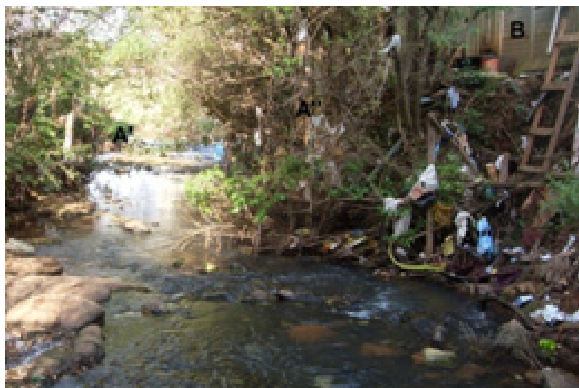
Figura 5. Modificação em trecho da rede de drenagem na bacia arroio Carro Quebrado Fotografia: Éderson Dias de Oliveira, março de 2011.
