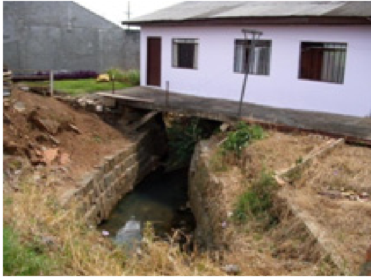
Figura 6. Moradia construída sobre tributário do arroio Carro Quebrado Fotografia: Éderson Dias de Oliveira, março de 2011.
