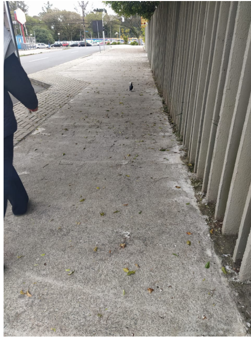
Figura 8. Calçada externa ao redor do prédio.
