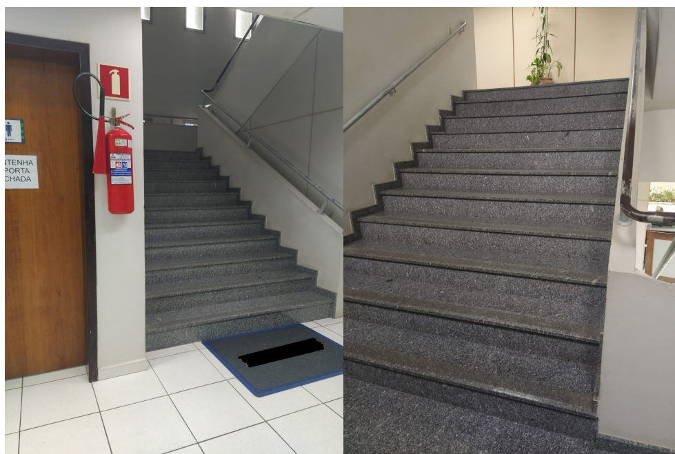
Figura 6. Primeiro pavimento do Bloco F Figura 7. Primeiro pavimento do Bloco F
